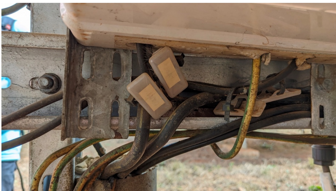
Figure 15 : Exemple d'étiquettes à remplacer, l'inscription a disparu
