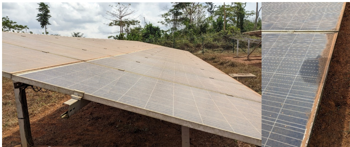
Figure 9 : Exemple de modules encrassés
