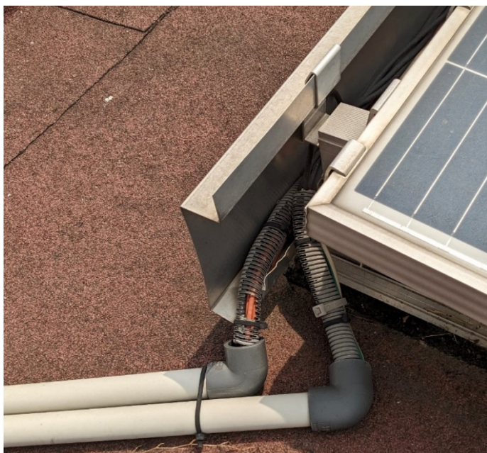
Figure 14 : Exemples de câbles exposés aux UV
