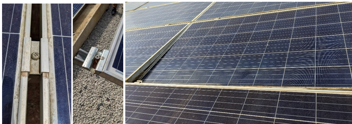
Figure 8 : Exemples de pinces de module devant être serrées ou remplacées
