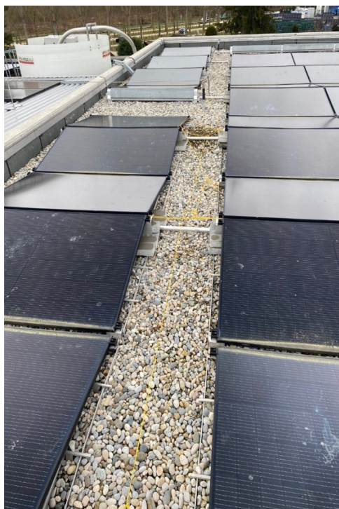
Figure 3 : Image des modules sales et d'une solution pour chasser les oiseaux
