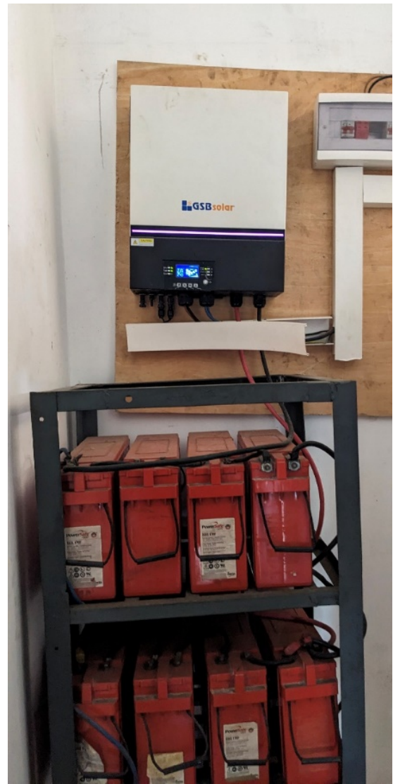
Figure 20 : Exemple de batterie trop serrée (gauche) et de batteries installées dans une pièce à vivre, avec un câblage non conforme
