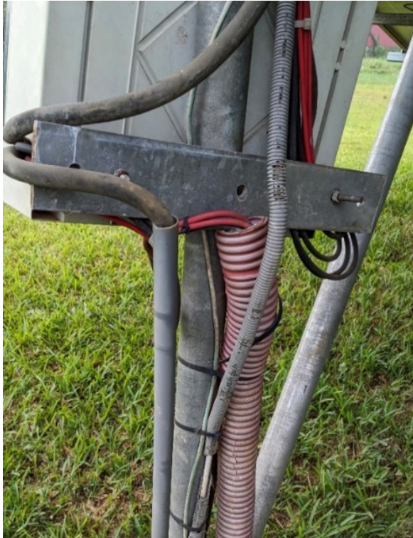
Figure 12 : Exemple de défauts sur les câbles DC et fourreaux (à gauche) et exemple respectant les meilleures pratiques (à droite)
