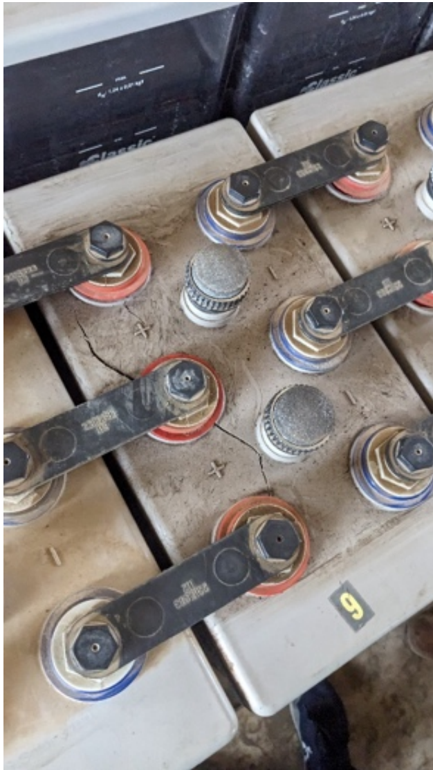
Figure 20 : Exemple de batterie trop serrée (gauche) et de batteries installées dans une pièce à vivre, avec un câblage non conforme
