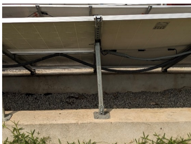
Figure 5 : Exemple de structure mal fixée (visserie manquante ou mal placée)
